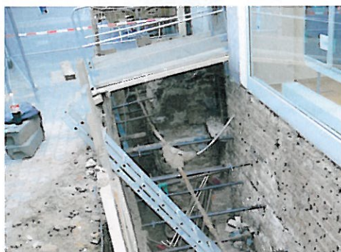
Aufwändige Erdarbeiten waren für die Abdichtung der Kellerwände erforderlich.
