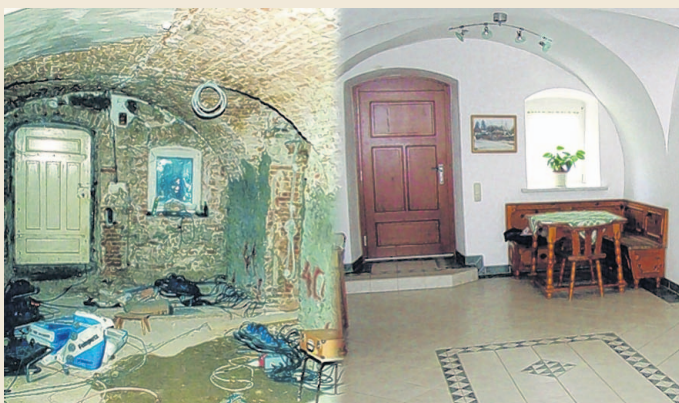
Ein Raum, zwei Welten: Das Bild rechts zeigt, wie ein Keller nach gelungener Sanierung durch den Fachmann aussehen kann. Foto: ISOTEC
