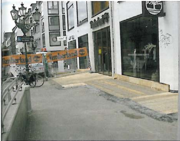
Abb. 3: Zugänglich gemachte Schaufenster- und Geschäftsbe- reiche sowie U-Bahnzone durch »gedeckelte« Baugrube
