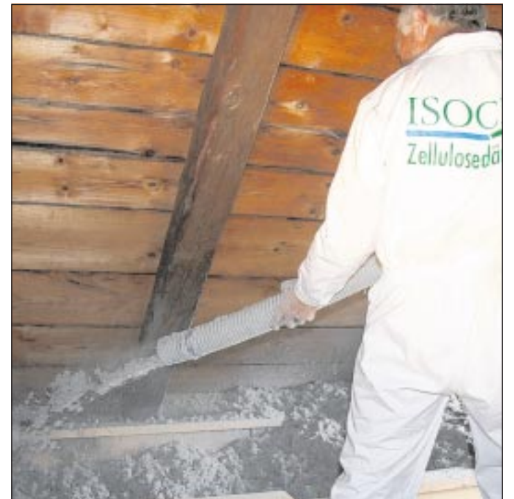
DIE ZELLULOSEFLOCKEN werden durch den Fachmann eingeblasen und füllen auch schwierige Stellen, engste Spalten und Ritzen fugenlos aus. (epr/Isocell)
