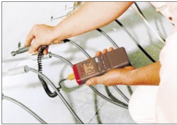
BEIM BOHRLOCH-INJEKTIONSVERFAHREN wird flüssiges Spezialparaffin in das Mauerwerk injiziert. Sobald es abkühlt, bildet das Paraffin eine wachsartige Sperre – aufsteigende Feuchtigkeit hat somit keine Chance mehr. (Isotec)
