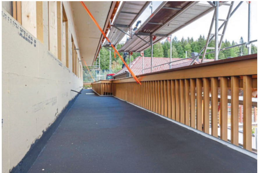
Zur dauerhaften Abdichtung der Balkone kam die Kombiflexabdichtung vollflächig auf den Untergrund.
