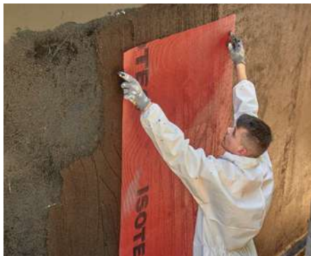
1 In die erste Lage der kunststoffmodifizierten Bitumendickbeschichtung wird eine Gewebeeinlage eingearbeitet.
