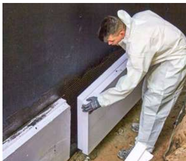
3 Nach der vollständigen Durchtrocknung des Isotec-VAS wurden spezielle Wärmedämmplatten aufgebracht.
