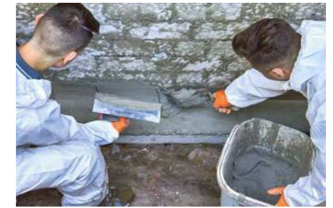
3 Im Bereich des Fundamentvorsprungs wird eine Hohlkehle erstellt.
