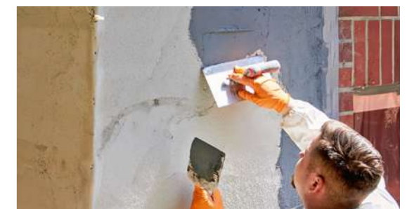
8 Im Sockelbereich wird eine mineralische Dichtschlämme zur Abdichtung aufgetragen.
