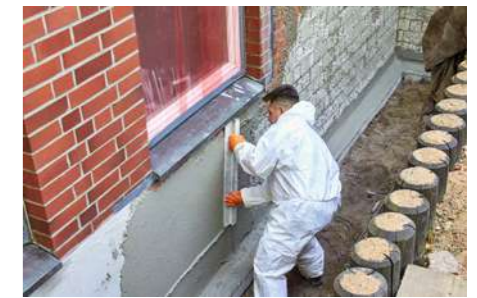
6 In den folgenden Arbeitsgängen wird der Dichtputz vollflächig aufgebracht.
