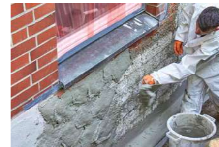
5 Auf den Spritzbewurf trägt der Fachhandwerker den Dichtputz auf.
