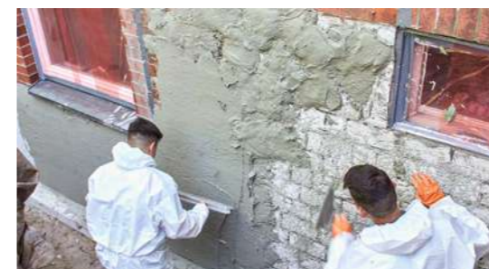
7 Mit einer Kartätsche wird der Dichtputz glatt gezogen. Sie eignet sich sehr gut zum Verputzen großer Flächen.
