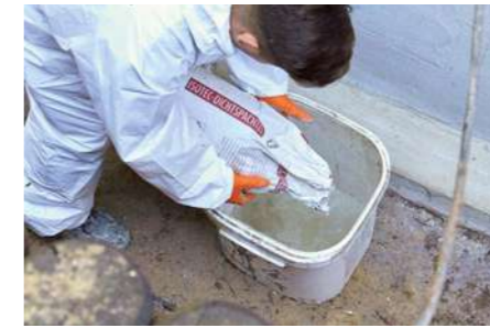
2 Hier wird der Dichtputz für die Außenabdichtung angemischt, die im Anschluss in einem mehrstufigen Verfahren aufgetragen wird.
