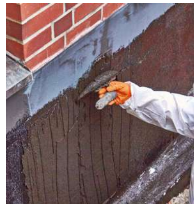
1+2 Die flexible Dickbeschichtung wurde von den Fachhandwerkern an allen Stellen des freigelegten Mauerwerks aufgetragen.
