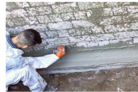
4 Die Hohlkehle bildet eine saubere, abgerundete Oberfläche. Sie dient zur besseren Haftung der nachfolgenden Abdichtungsschichten.
