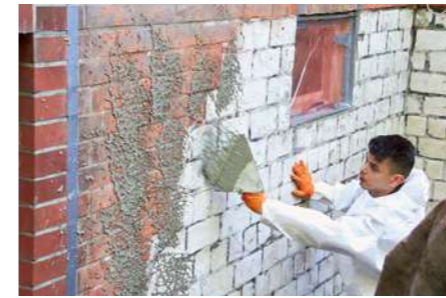
1 Damit der Dichtputz auf dem Mauerwerk hält, wird das Mauerwerk mit einem Spritzbewurf überzogen.
