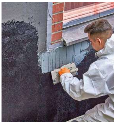
1+2 Die flexible Dickbeschichtung wurde von den Fachhandwerkern an allen Stellen des freigelegten Mauerwerks aufgetragen.
