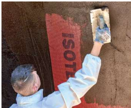
2 Im Anschluss wird eine weitere Lage der Isotec-VAS-Abdichtung aufgebracht.
