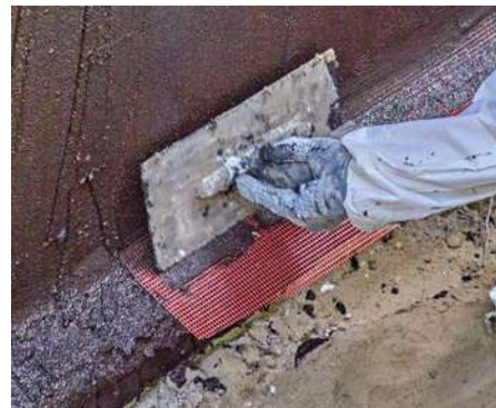
3 Mit der flexiblen Dickbeschichtung wird ein Abdichtungssystem erstellt, das höchsten Anforderungen entspricht.
