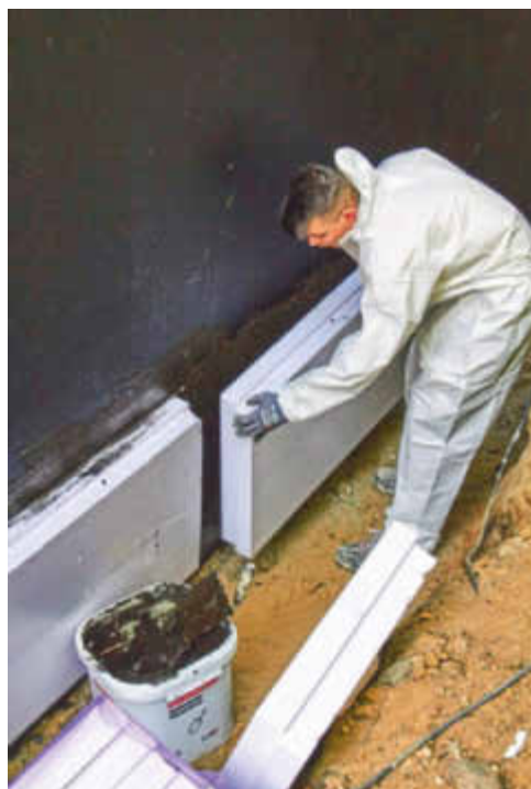
Die neue Außenabdichtung wird mit Polystyrolplatten gegen mechanische Beschädigungen geschützt.
