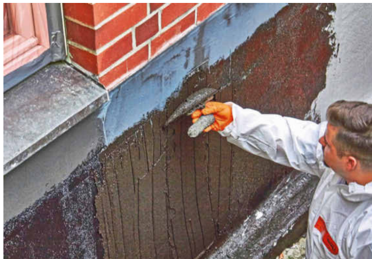
Die flexible Dickbeschichtung wurde mehrlagig an allen Stellen des freigelegten Mauerwerks aufgetragen.
