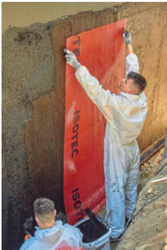
Erste Lage der kunststoffmodifizierten Bitumendickbeschichtung mit eingearbeiteter Gewebeeinlage.
