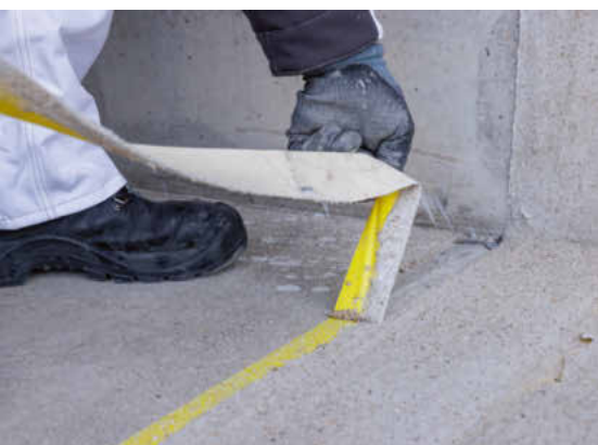
Die großen Dehnungsfugen der Treppe wurden mit dem Flexbandsystem dauerhaft abgedichtet.
