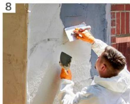
1 Damit der Dichtputz auf dem Mauerwerk hält, wird das Mauerwerk mit einem Spritzbewurf überzogen.
