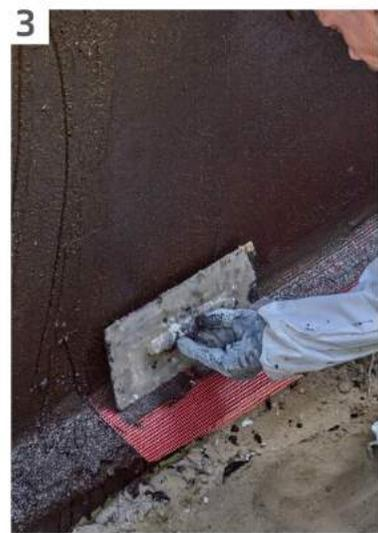
3 Mit der flexiblen Dickbeschichtung wird ein Abdichtungssystem erstellt, das höchsten Anforderungen entspricht.
