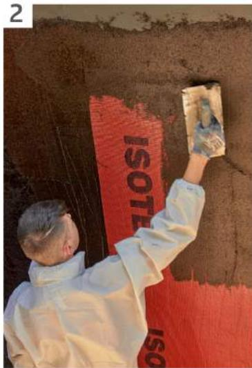
2 Im Anschluss wird eine weitere Lage der Isotec-VAS-Abdichtung aufgebracht (Gesamtdicke min. 4 mm Abdichtungsschicht).
