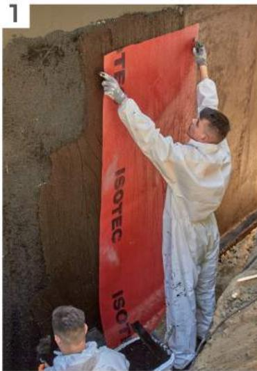
1 In die erste Lage der kunststoff-modifizierten Bitumendickbeschichtung (Isotec-VAS) wird eine Gewebeeinlage eingearbeitet.
