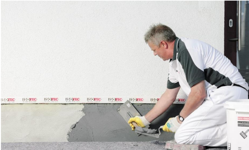
Abb. 4 Auftrag FPD als Sockelabdichtung
