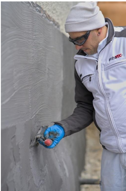
Abb.3 Nachträgliche Außenabdichtung mit FPD
