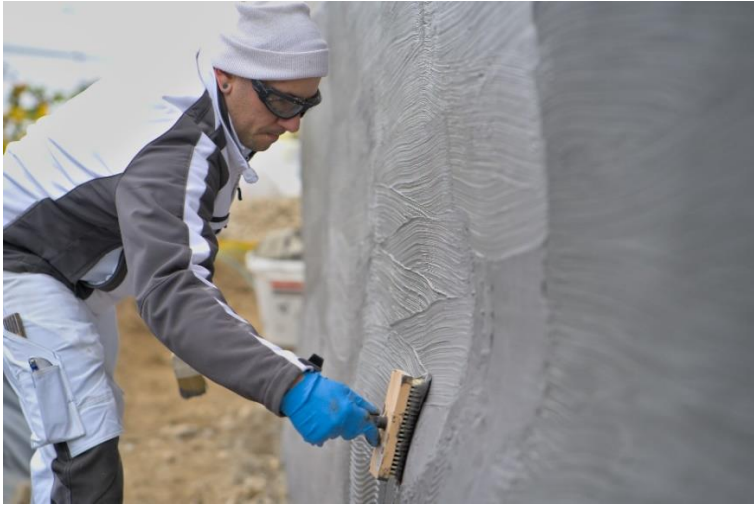
Abb. 13 Auftrag FPD mittels Quast
