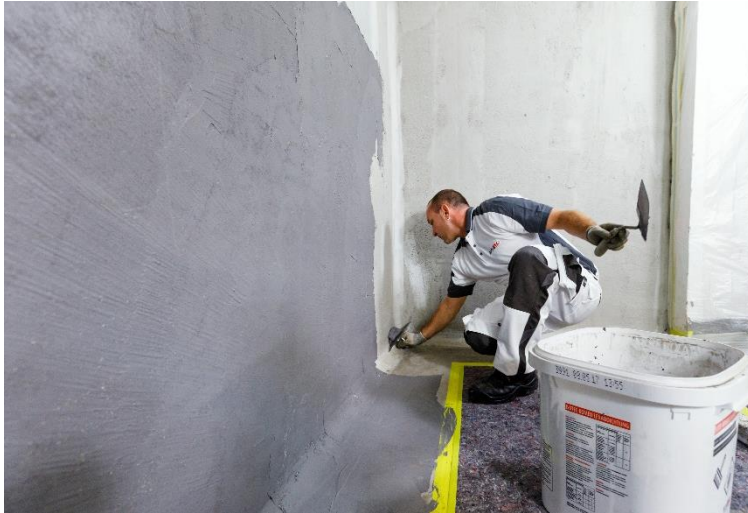
Abb. 8 Kratzspachtelung der FPD bei einer Innenabdichtung
