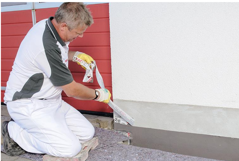
Abb 5. Fertigstellung der Putzabdichtung mit FPD
