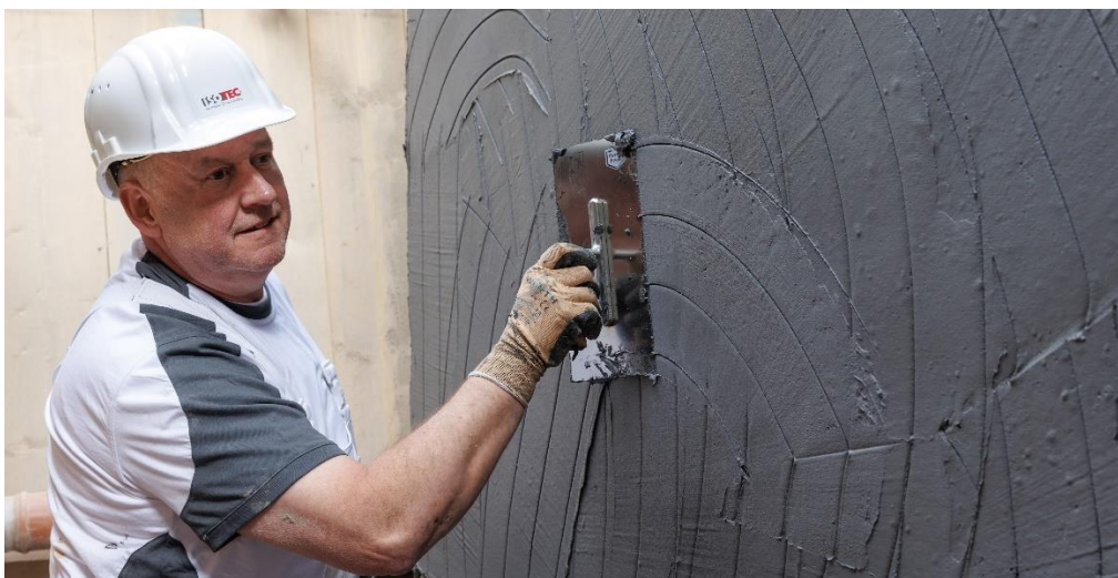
Abb. 12 Auftrag FPD mittels Schichtdickenglätter
