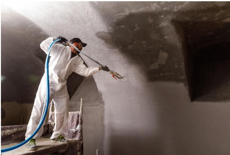
Abb. 14 Auftrag FPD zur Innenabdichtung in einem Gewölbekeller mittels Schneckenpumpe
