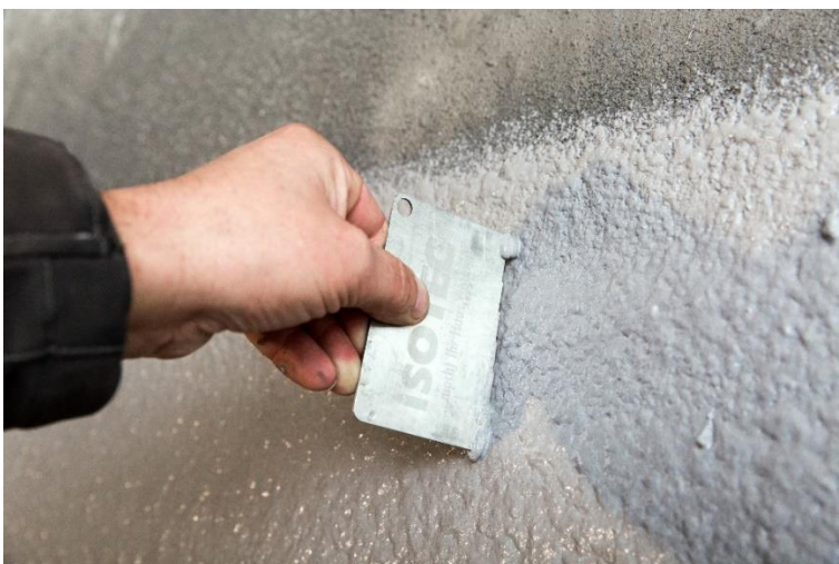
Abb. 15 Kontrolle der Schichtdicke
