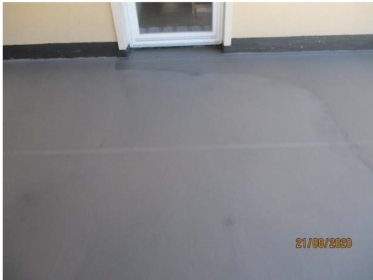
Abb. 10 Balkonabdichtung mit FPD
