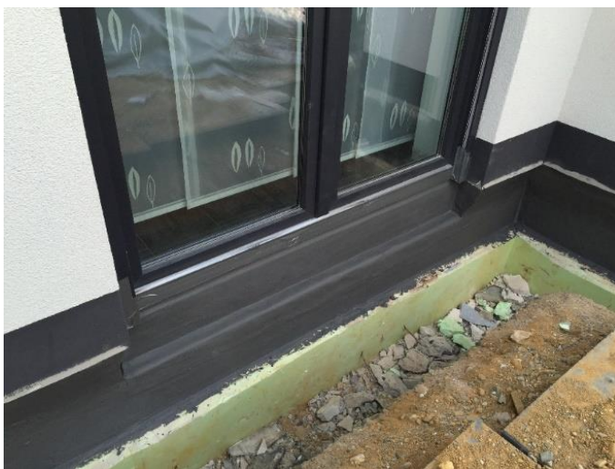
Abb. 6 Eindichtung bodentiefer Fenster
