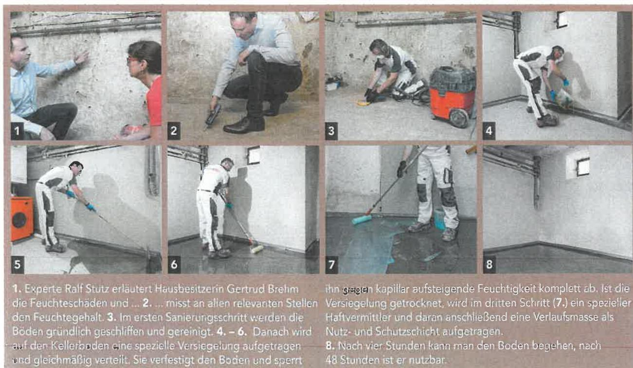
1. Experte Ralf Stutz erläutert Hausbesitzerin Gertrud Brehm die Feuchteschäden und ... 2. ... misst an allen relevanten Stellen den Feuchtegehalt. 3. Im ersten Sanierungsschritt werden die Böden gründlich geschliffen und gereinigt. 4. – 6. Danach wird auf den Kellerboden eine spezielle Versiegelung aufgetragen und gleichmäßig verteilt. Sie verfestigt den Boden und sperrt
