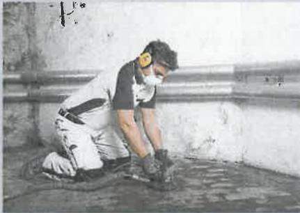
Der Boden wird zunächst von Verunreinigungen befreit. Offene Fugen werden verschlossen und Vertiefungen grob egalisiert. Anschließend wird die Oberfläche gründlich gesäubert.
