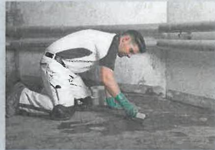
Auf den Boden trägt der Sanierprofi eine spezielle Versiegelung auf und verteilt sie. Diese erste Schicht sorgt für eine Verfestigung des Bodens und sperrt ihn gegen Kapillarfeuchte.
