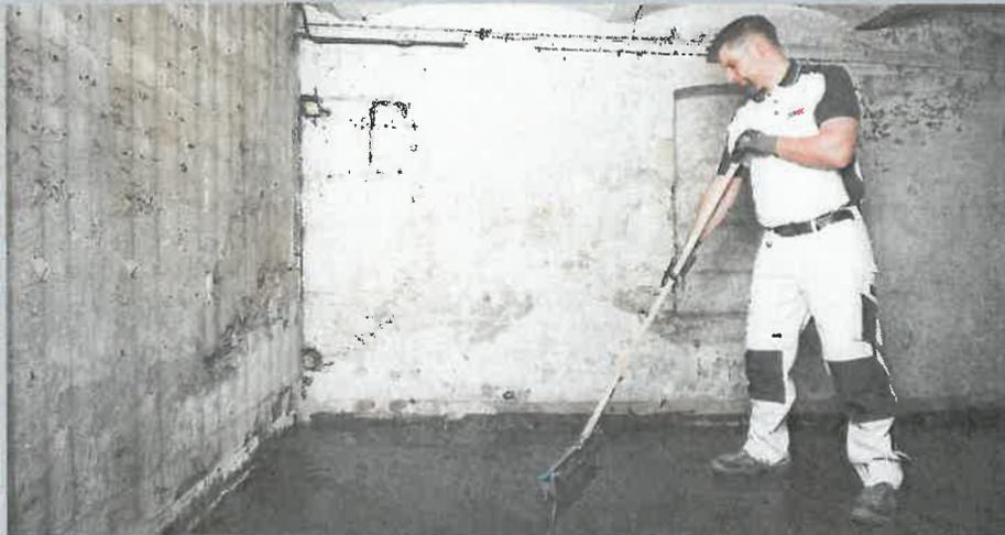
Nach Durchtrocknung der Versiegelung trägt der Fachmann einen speziellen Haftvermittler auf. Darauf wird eine Verlaufsmasse aufgebracht, welche im abgebundenen Zustand die Schutz- und Nutzschicht darstellt. Abschließend kann der Boden mit spezieller Bodenfarbe nach Kundenwunsch gestaltet werden.
