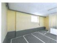
Die Kelleraußenwand wurde von innen auf einer Höhe von 50 Zentimetern abgedichtet.
