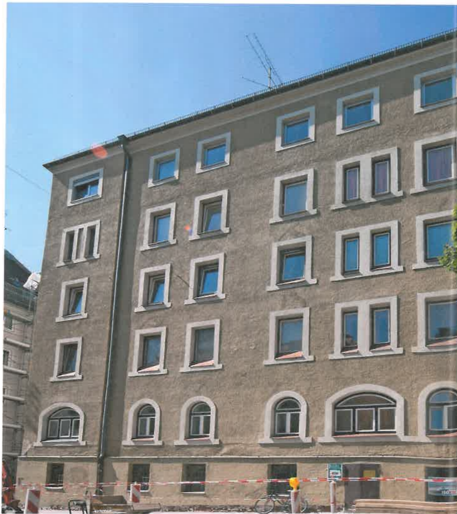
Ein Gebäude aus dem 19. Jahrhundert wurde mit Mauerwerkstrockenlegung im Untergeschoss saniert.
