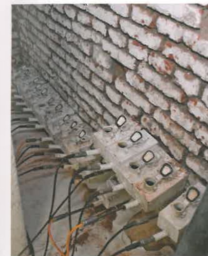
Bohrloch-Injektionsverfahren: Heizstabtechnologie trocknet den Wandabschnitt, bevor Spezial-Paraffin als nachträgliche Horizontalsperre eingeführt wird.
