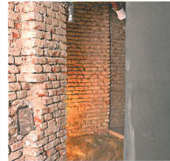
Zur Innenabdichtung wurden auf den kunststoffvergüteten Ausgleichsputz zwei Lagen mineralischer Dichtungsschlämme aufgebracht.
