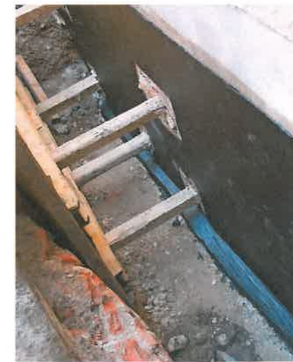
Kunststoffmodifizierte Bitumendickbeschichtung sorgt für eine rissüberbrückende Außenabdichtung.
