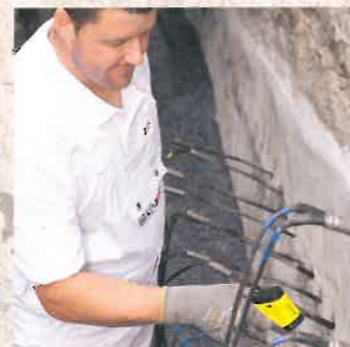
Bevor das Paraffin zum Einsatz kommt, wird die Kellerwand mit Heizstäben getrocknet. Hier misst der Handwerker die Temperatur des Mauerwerks.
