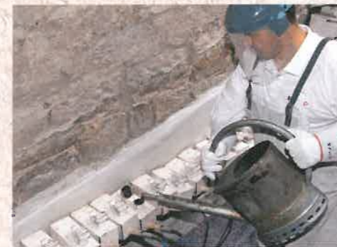
Spezielles Paraffin wird in die Behälter gegossen. Das Material hat versiegelnde Wirkung und macht das Mauerwerk damit „immun“ gegen Feuchtigkeit.
