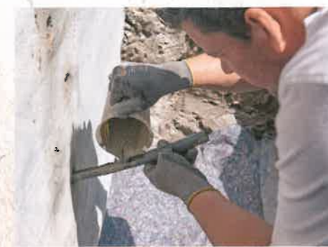
Die Bohrlöcher werden mit einer Zementsuspension verschlossen.
