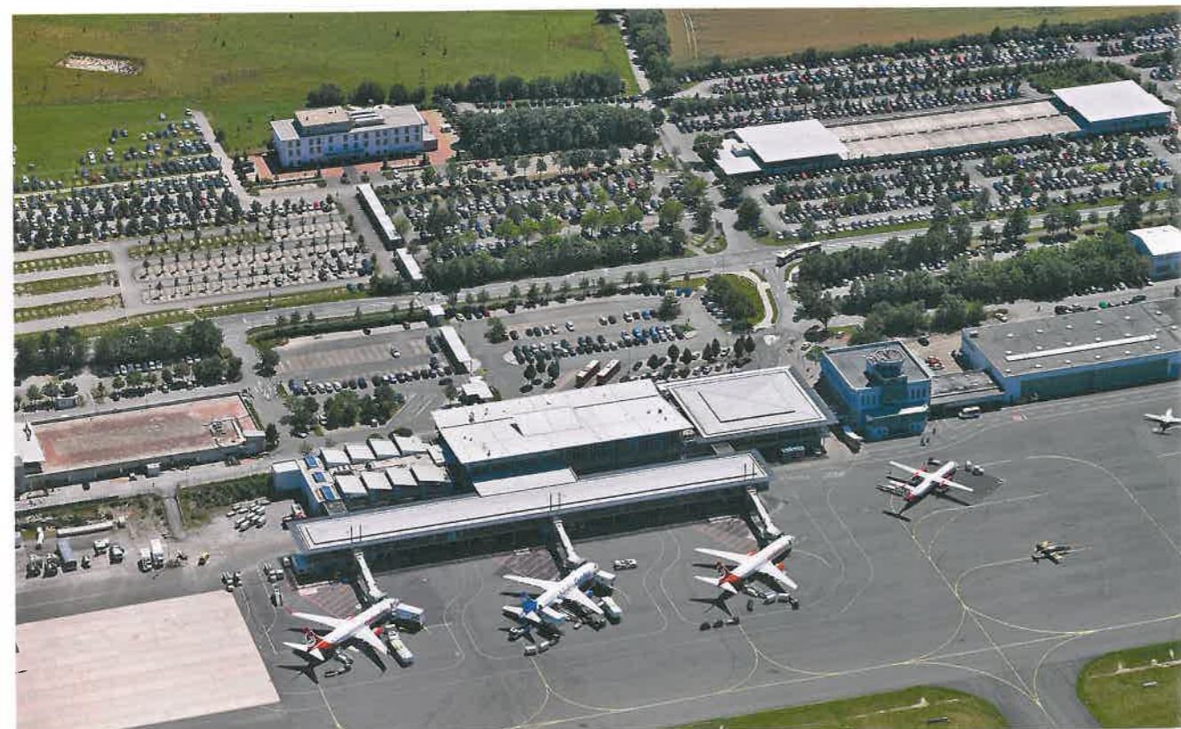
Luftaufnahme: Für die Zukunft ist das Parkhaus (links Mitte) wieder dicht und trocken. Bild: Flughafen Paderborn
