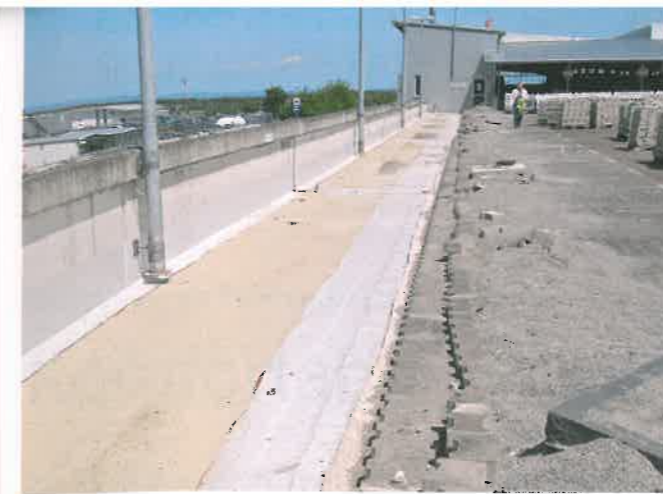
Sanierung des Betonbauteils: Rand- und Rampenabdichtung mit Flexband sowie Flüssigkunststoffabdichtung bei zehn Bodeneinläufen. Bild: Isotec
