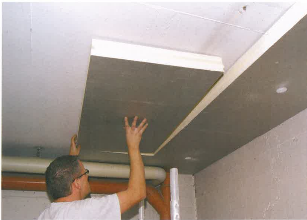
Dämmung der Kellerdecke mit Platten aus PIR, oder Polyisocyanurat, dem etwas robusteren Verwandten des Polyurethans.
