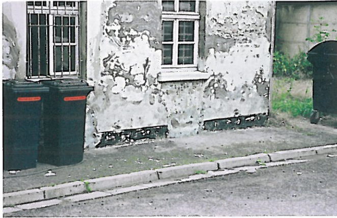
Feuchtigkeit hat oft Bauschäden im Schlepptau. Hier sind die Schäden am Putz des Hauses aufgrund von Salzkristallisation deutlich zu sehen
