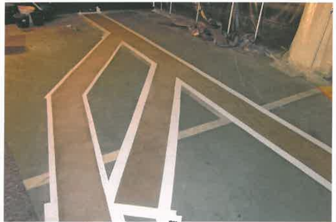
Nach einer Rissinjektion wurden Risse in der Bodenbetonplatte zusätzlich mit einem Flexband verklebt.
