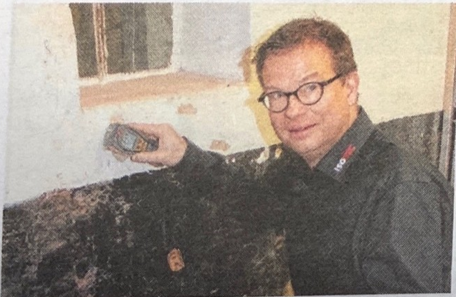
Teichert misst den Feuchtigkeitsgehalt der Wand.
