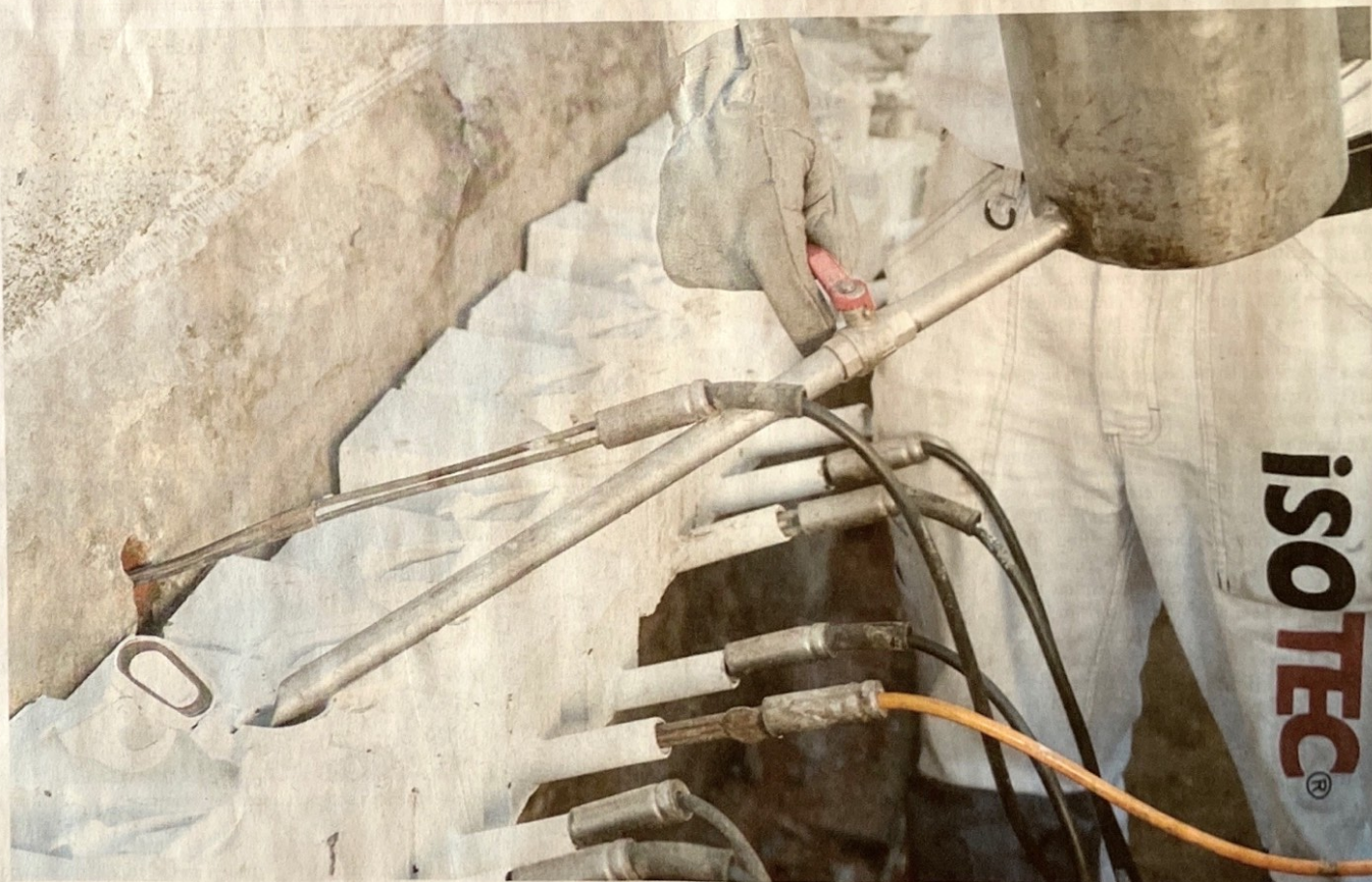
Über Bohrungen bringt Teichert das ISOTEC-Paraffin gegen aufsteigende Feuchtigkeit ins Mauerwerk des zu sanierenden Gebäudes ein
