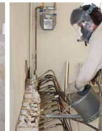
► Joachim Zorn füllt Paraffin in die speziell von Isotec entwickelten Behälter nach.
