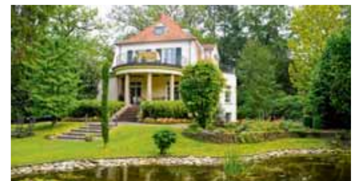
Damit ein so schönes Haus wie dieses seinen Wert behält, sollte man bei Feuchtigkeitsschäden sofort handeln und Experten wie die von Isotec zu Rate ziehen. Foto: A. Henk
