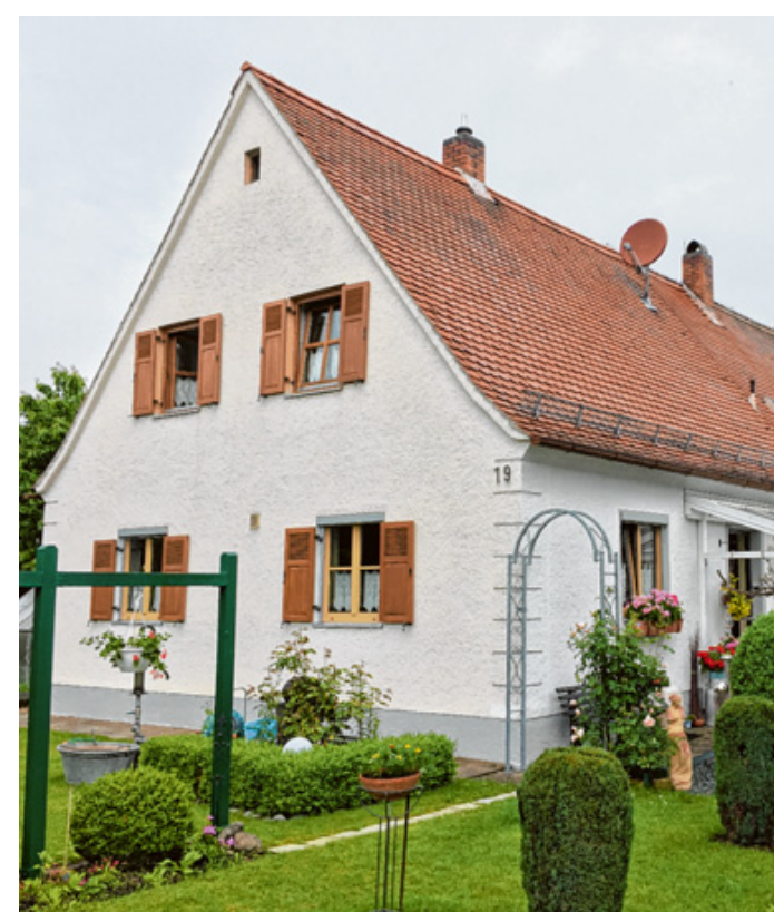
Wer seine Immobilien renoviert, sollte nicht nur auf Bauästhetik, sondern vor allem auch auf Bauschäden wie Feuchtigkeit achten. Foto: oH
