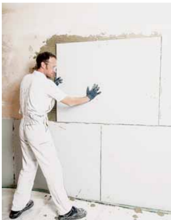
Dank der diffusionsoffenen ISOTEC-Klimaplatzen kann man einem erneuten Schimmelbefall vorbeugen. Foto: ISOTEC
