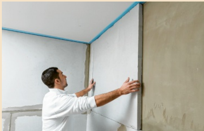
Die ISOTEC-Klimaplatte verhindert Kondensation und Schimmelpilzbefall und sorgt für ein gesundes Wohnklima. Foto: Isotec
