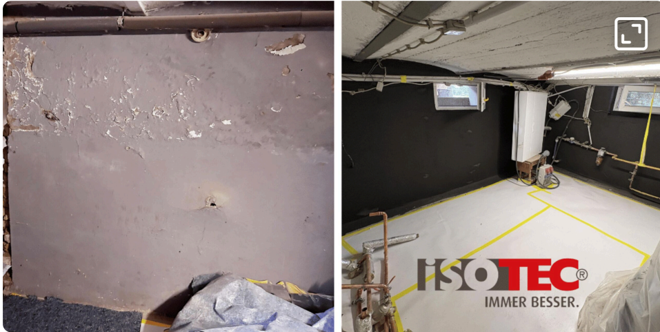
Nach der Abdichtung kann der ehemals feuchte Kellerraum wieder genutzt werden. © ISOTEC-Fachbetrieb
