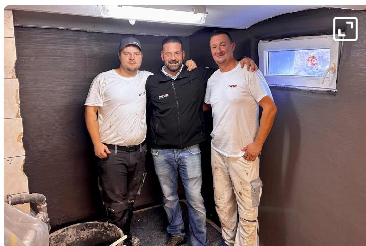
Die Arbeiten stehen vor dem Abschluss. Im Hintergrund ist schon eine sanierte Wand zu sehen. © Petra Zimmermann
