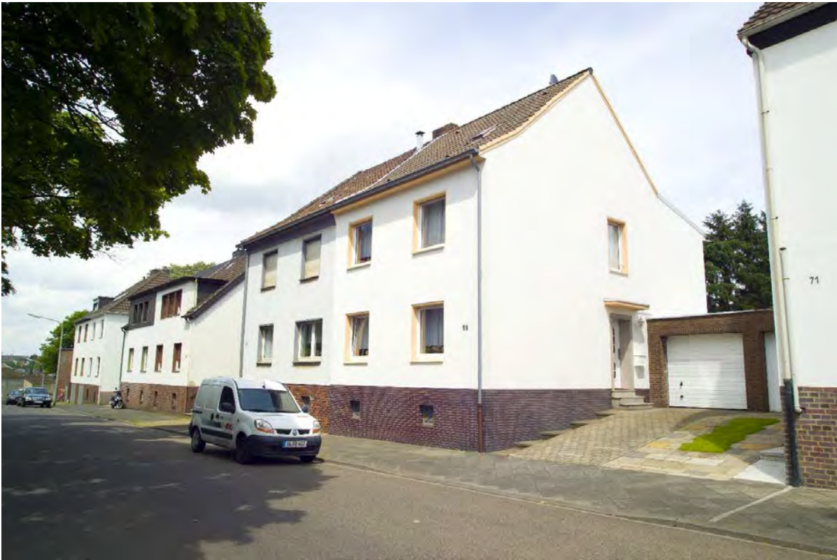
Objekt vor der Ausführung
