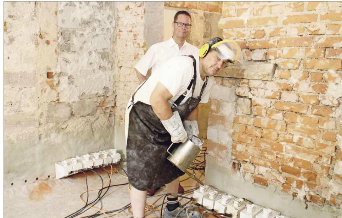
Mauertrockenlegung im Rathaus Weisenbach: Paraffin bildet eine Sperre für aufsteigende Feuchtigkeit.
