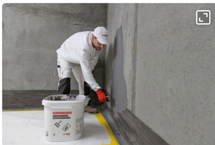
Sorgfältige Handarbeit: Die Abdichtung wird präzise aufgetragen, um das Mauerwerk dauerhaft vor Feuchtigkeit zu schützen. © ISOTEC
