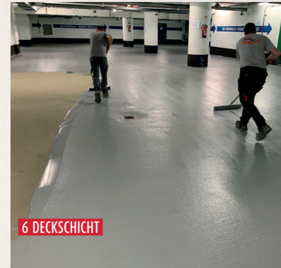
Aufbringen einer rissüberbrückenden Deckschicht
