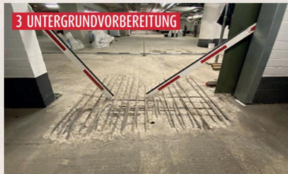
Partielle UV durch Abtragung von schadhaftem Beton
