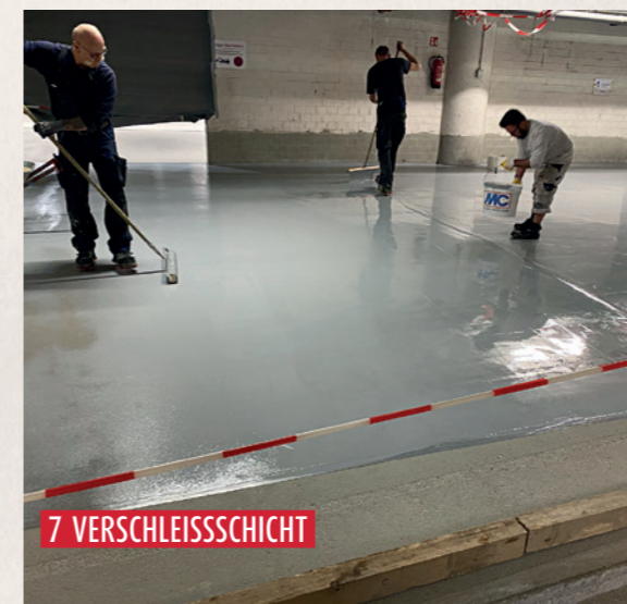
Aufbringen einer Verschleißschicht mit Kopfversiegelung
