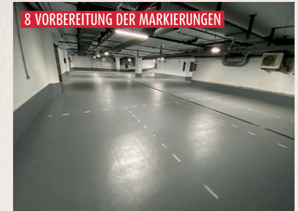
Fertige OS 10 Beschichtung vor den Markierungsarbeiten
