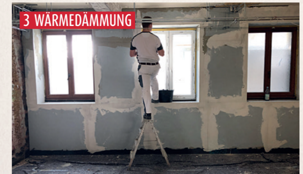
Verspachteln der Calcium-Silikatplatten
