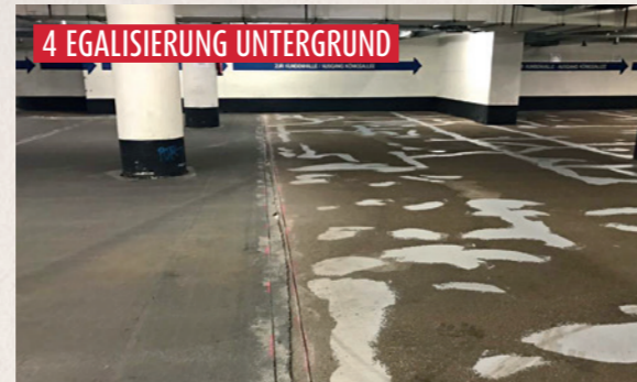
Partielle Egalisierung von Ausbrüchen und Fugen
