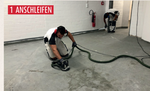
Anschleifen des Altbelags
