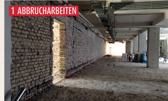
Entfernen des Wand- und Bodenaufbaus
