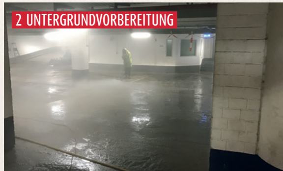
Höchstdruckwasserstrahlen (1100 Bar)
