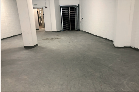
FAHRRADKELLER VOR SANIERUNGSBEGINN
