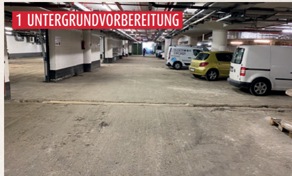
Entfernung des alten Asphaltbelages
