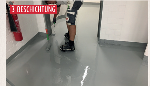
Auftrag der Beschichtung
