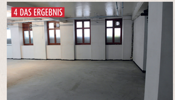
ISOTEC-Innenabdichtung mit Calcium-Silikatplatte
