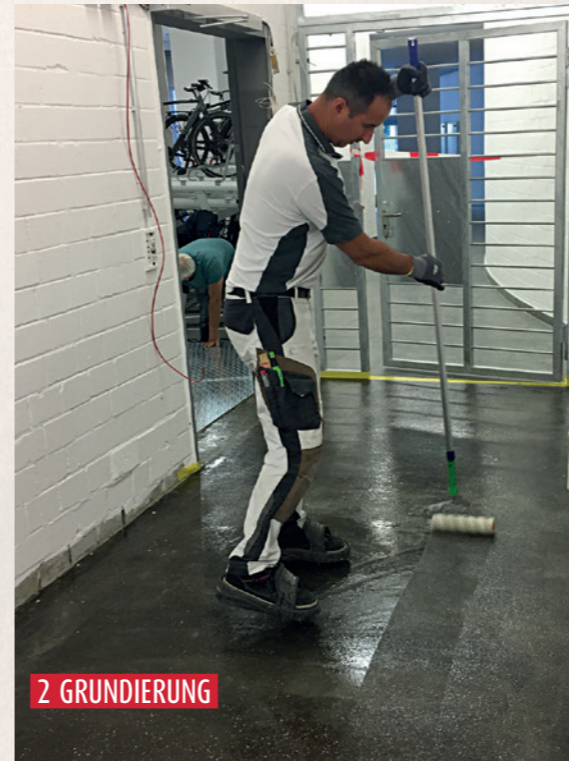
Auftrag der Grundierung
