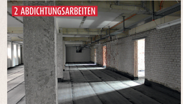
Abgeschweißte Betonbodenplatte
