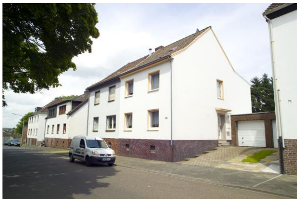
Objekt vor der Ausführung
