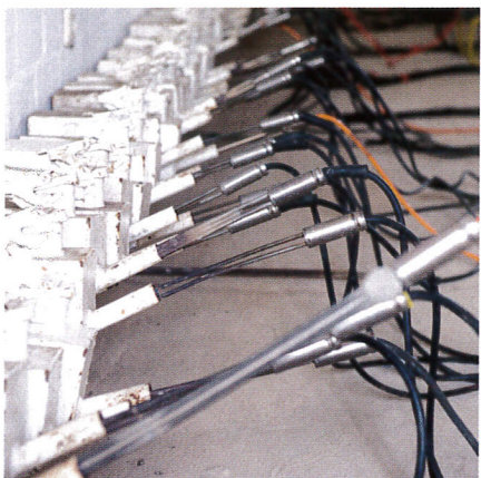
Ein spezielles Bohrloch-Injektionsverfahren gewährleistet die Horizontalsperre und trockene Mauern auch langfristig.
